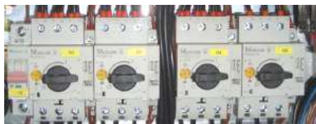
Рис. 1: Защитный выключатель электродвигателя
