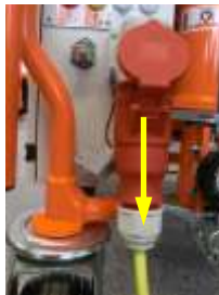
Рис. 108: Удаление соединительного кабеля
