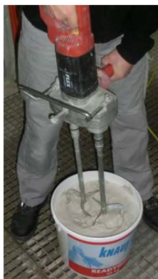
Рис. 23: Перемешивание материала
