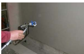
Рис. 40: Распыление материала
